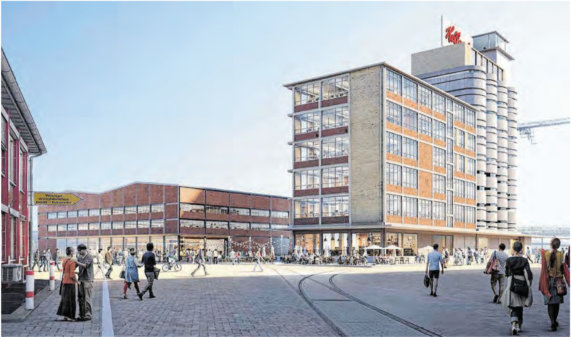
Ein Blick auf das zukünftige Gelände: Während im früheren Silo Hotelgäste schlafen sollen, dreht sich in den umliegenden Gebäuden alles um Lebensmittel.
