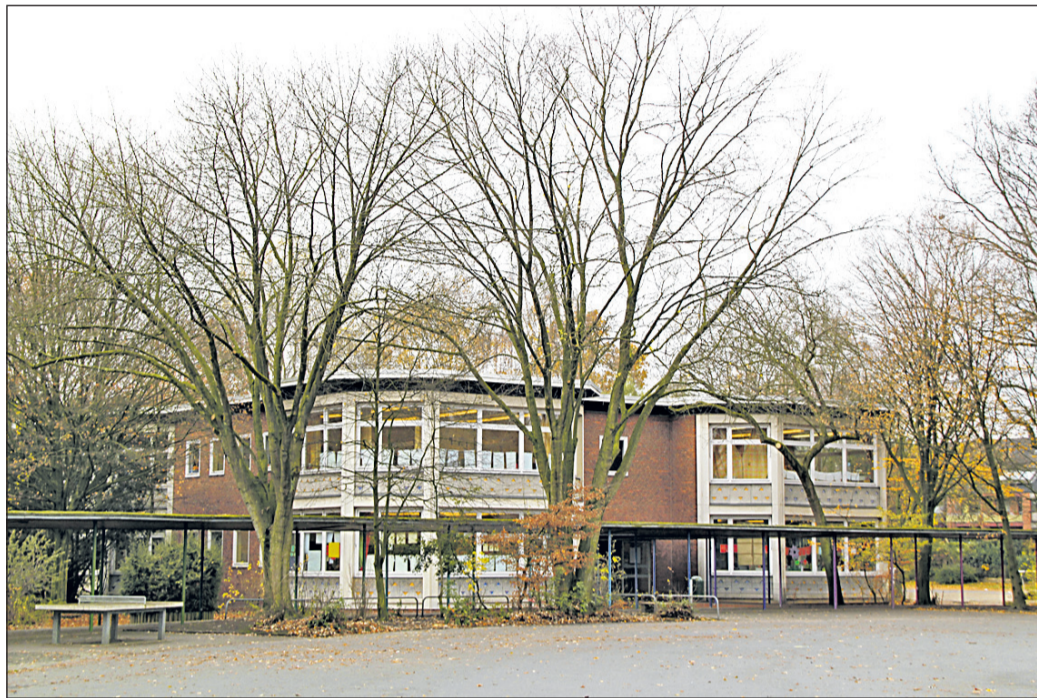
Ein Teil der Grundschule Halmer Weg
